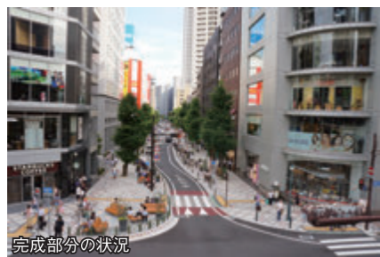
完成部分の状況
