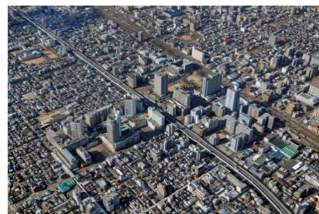
新長田駅南地区市街地再開発事業（現況）
