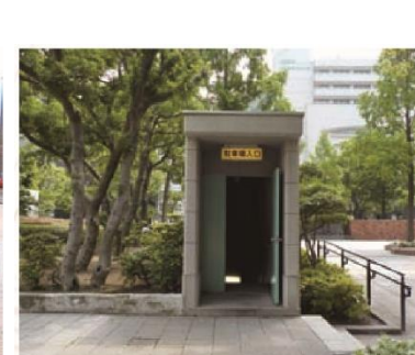
地下駐車場出入口
