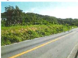
歩道がなく、路側帯も狭 い。大変危険。
