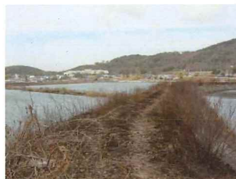
ため池の土手と管理道
