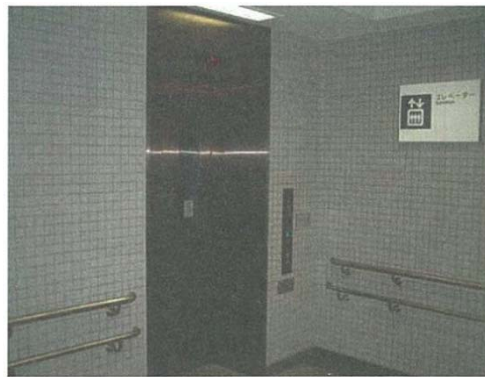
写真3-3-4 乗降口付近における手すりの設置例
