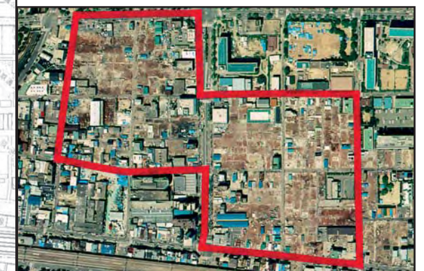
震災後 平成7年5月
