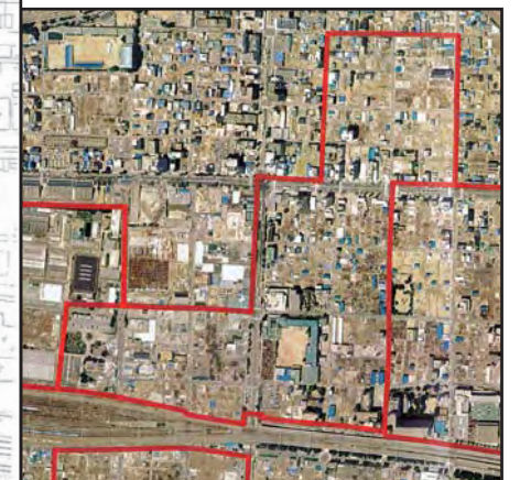
震災後 平成7年5月
