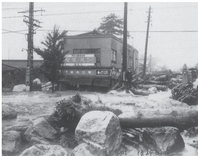
住吉川 阪神国 昭和13年阪神大洪水 - 住吉川国道2号線付近 - (神戸市文書館提供)
