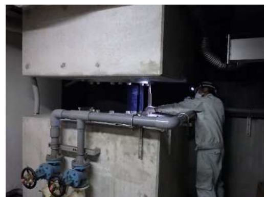
図 85 旧外国人居留地十五番館免振装置と点検状況（撮影協力：株ノザワ）
