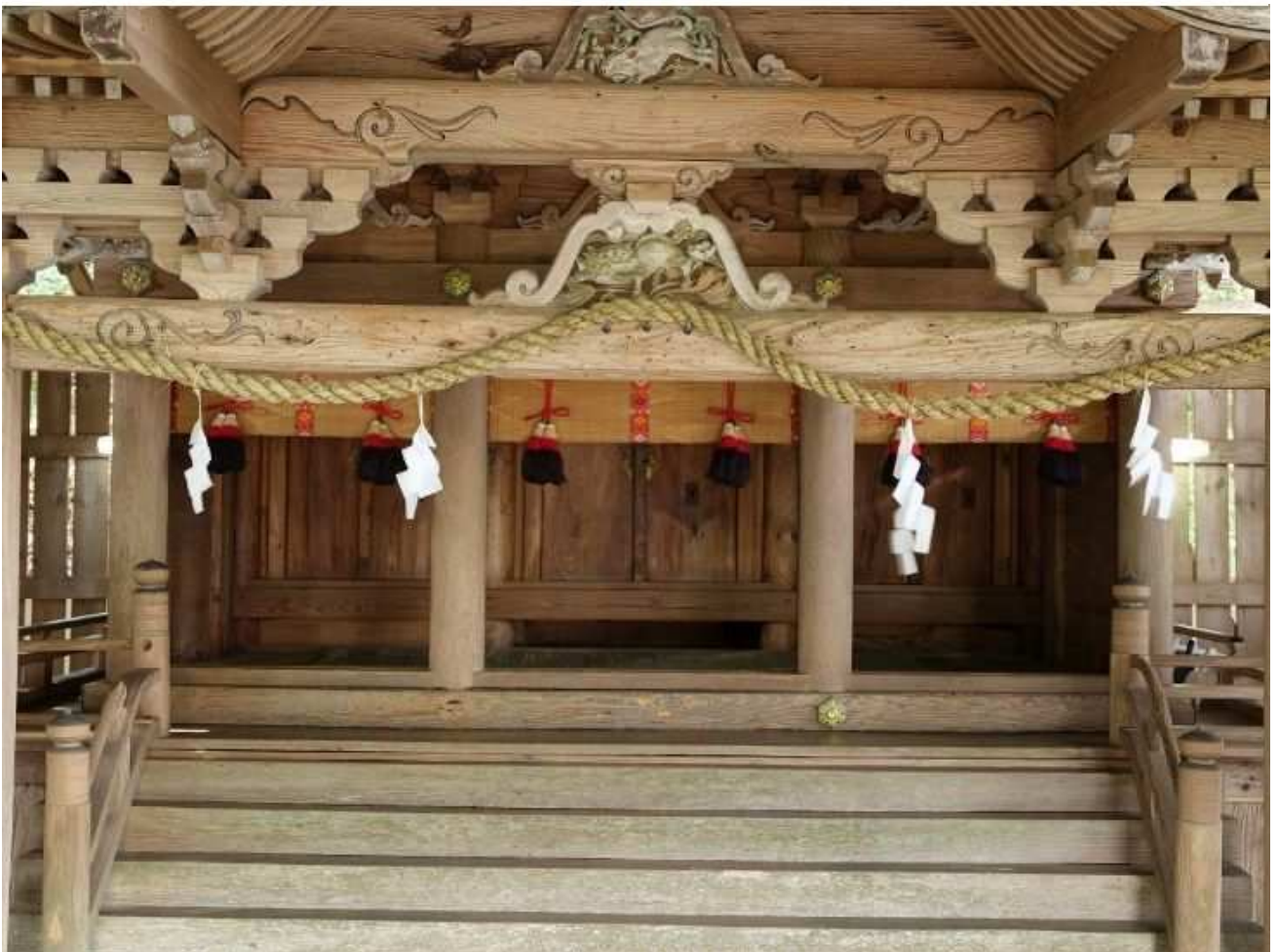
正面外陣内部
