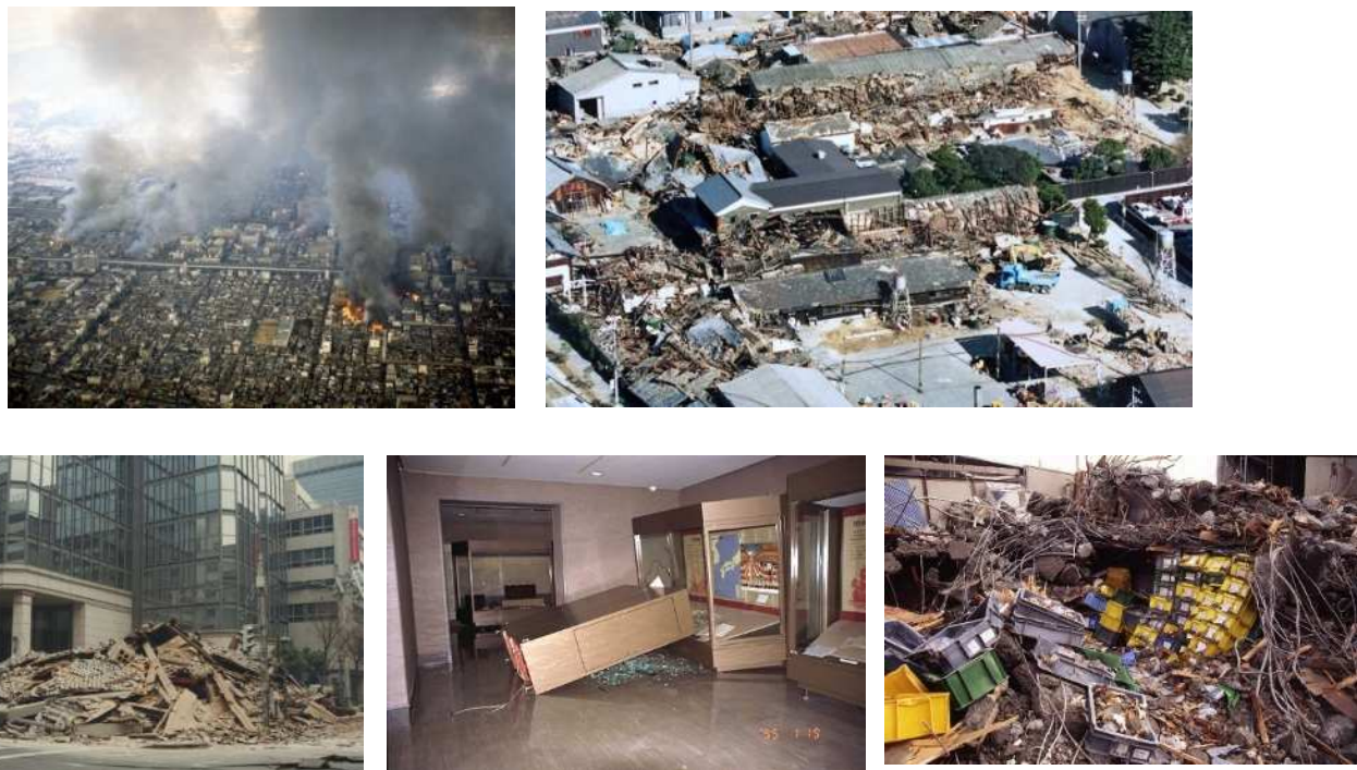
図 53 阪神・淡路大震災の被災状況(左上：JR 新長田駅～鷹取駅付近、右上：魚崎南町 5 丁目櫻正宗周辺、左下：旧神戸居留地十五番館、中央下：神戸市立博物館（神戸市立博物館提供）、右下：市内埋蔵文化財収蔵施設）
