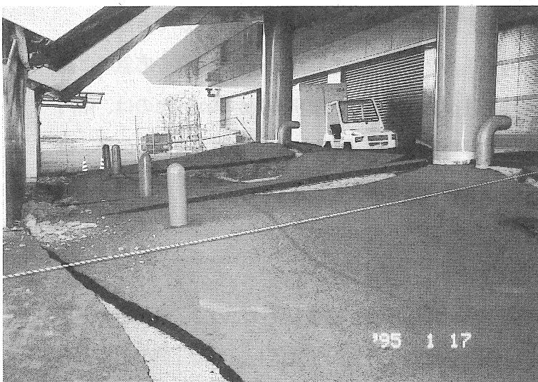
ターミナル東側（ブリッジ下部付近）
