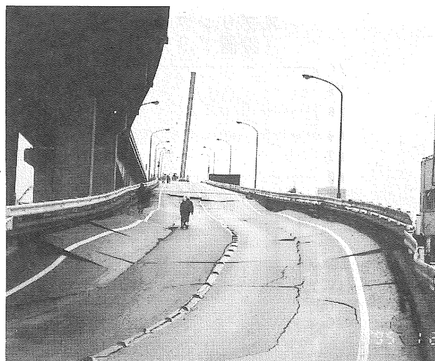
摩耶大橋西行き（灘区摩耶埠頭）
