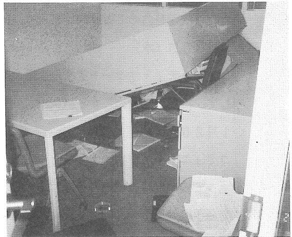
役員用個室の地震後の状況と改修状況
