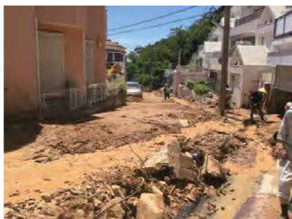
7月豪雨の直後の篠原台の様子。土砂が道路や住宅内に流入し、避難指示が出されました。
