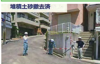
堆積土砂撤去済 その後、篠原台では堆積土砂は撤去され、8月10日に避難指示が解除されましたが、全壊12件を含む被害が発生しています。
