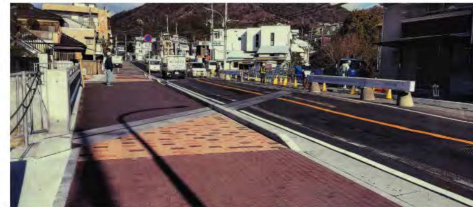
写真:2019.1.16明神橋架替工事が終了
