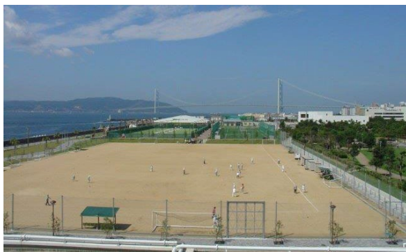
垂水処理場・上部利用施設
