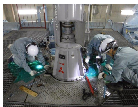
設備の補修・修繕作業
