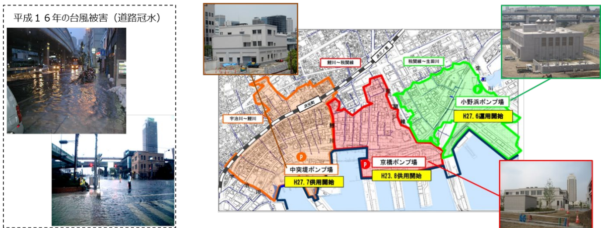
三宮南地区での雨水ポンプ場の整備
