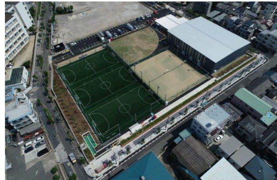
中部処理場跡地の利用(スポーツ施設)
