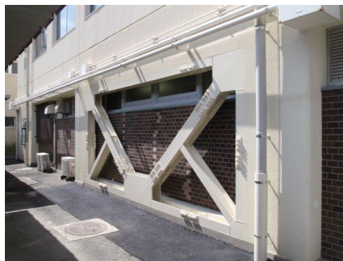
施設の耐震補強例(ブレース)
