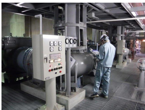
設備の点検・調査作業
