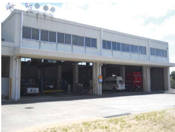
消防局整備工場（市民防災総合センター内）
