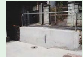
福住通3丁目での手すりの設置
