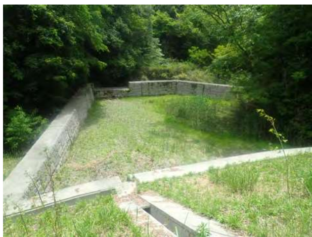
写真 4.1-2 神戸地区かんきつ山法対策他工事箇所下流の沈砂池
