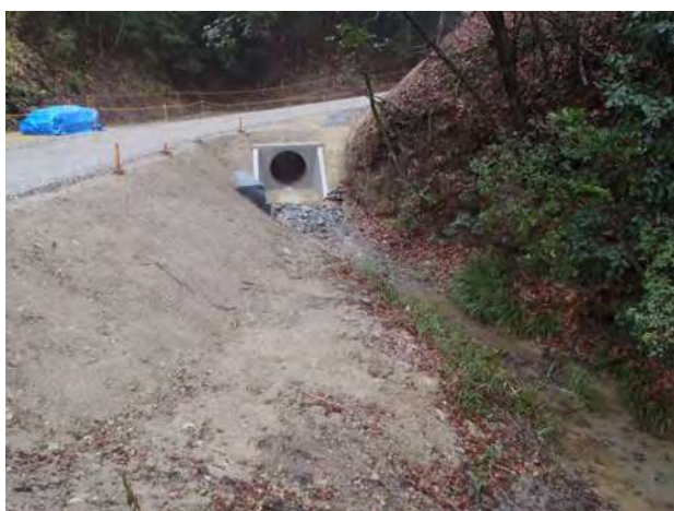
写真 4.1-1 渡河部の転流工の状況
