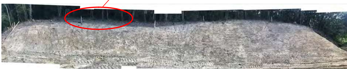
写真 4. 3-1 切土法面の状況
