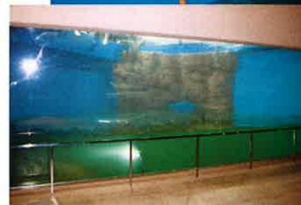
アク抜き中のトンネル水槽
