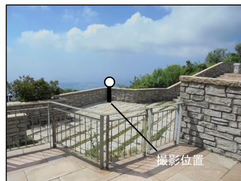
撮影位置周辺の状況
