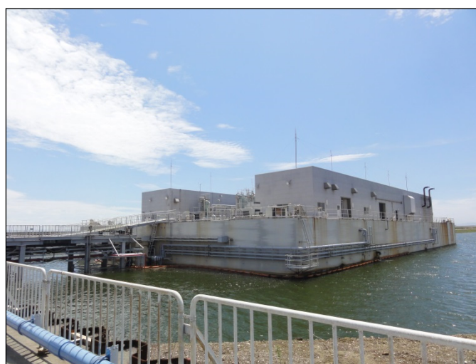
付図 9 2期神戸沖埋立処分場 排水処理施設
