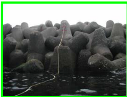
傾斜護岸（消波ブロック護岸）
