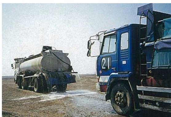
埋立処分場における場内散水
