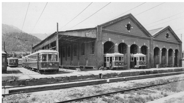
復旧した布引車庫（昭和23（1948）年）
