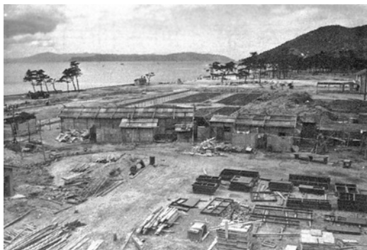
着工直前の須磨水族館建設予定地
