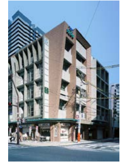
若松4第3工区 (アスタエクスタ南棟)
