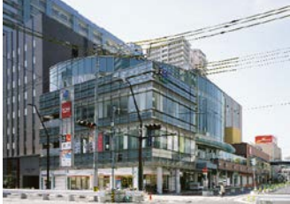
若松5第1工区(アスタプラザファースト)
