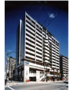
大橋4第3工区 (ステーションフラッツ)
