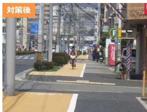
※路肩に幅員が確保できないため広い歩道を活用している 「普通自転車の通行指定部分」
