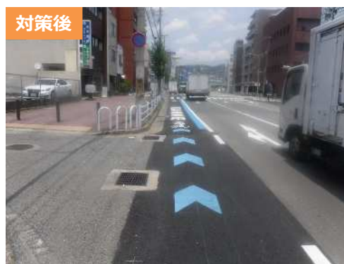
※既存の路側帯を活用している 「自転車専用通行帯(自転車レーン)」
