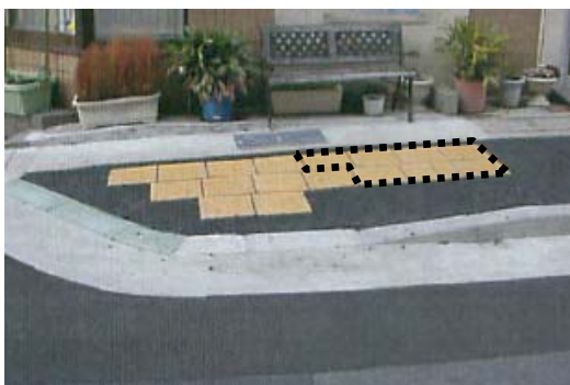
必要のない箇所にブロック(端部は点状ブロック)を設置している。(垂水区)
