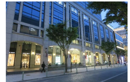
【ショーウィンドーの照明演出事例】
