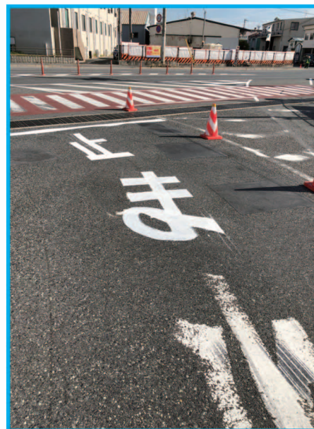
⑲ 魚崎浜インター出口の緊急補修工事
