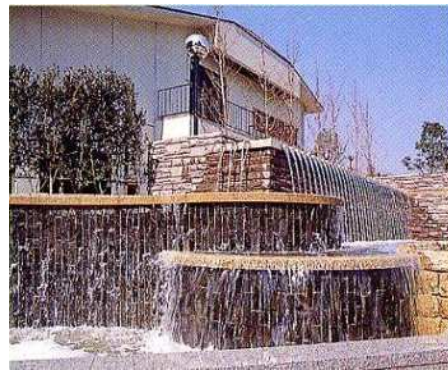
水リサイクルセンター (六甲アイランド)
