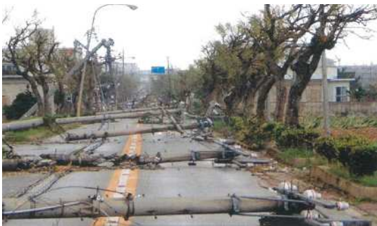
災害時の被害イメージ (近畿地方整備局「無電柱化推進に向けて」より抜粋)
