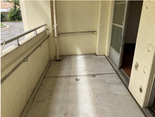
□ベランダ・スロープ
