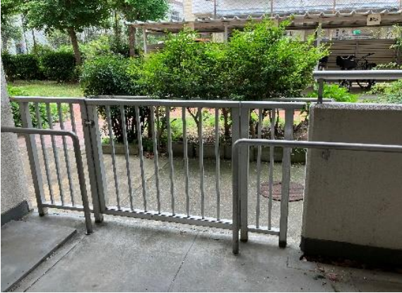
□ベランダ・スロープ
