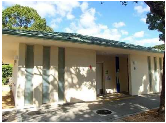
公園トイレチェンジアクション（須磨離宮公園）
