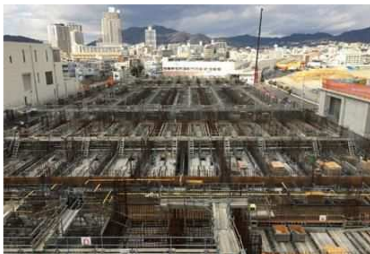
西部処理場北系整備
