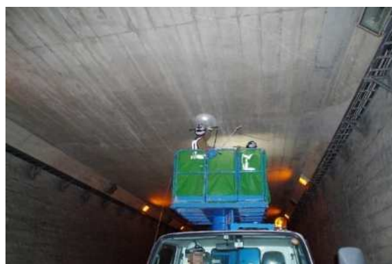
トンネル点検（須磨区 玉坂トンネル）
