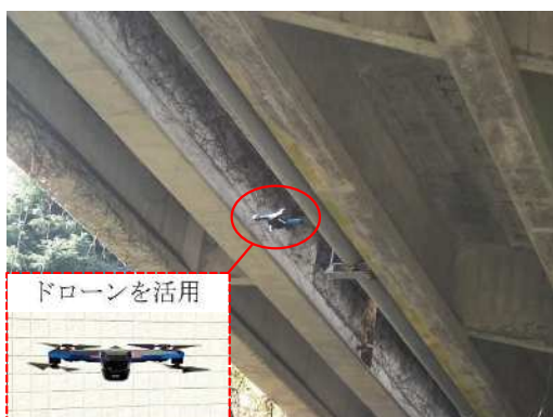
橋梁点検（東灘区 渦森橋）
