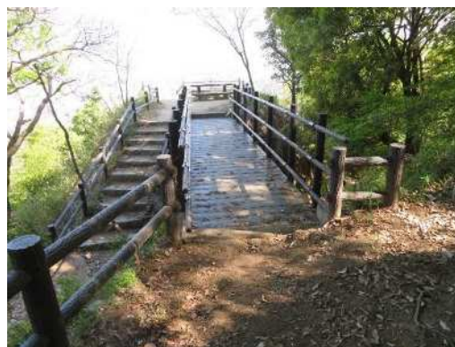
歩行空間の整備(橋の改修)(上野道)
