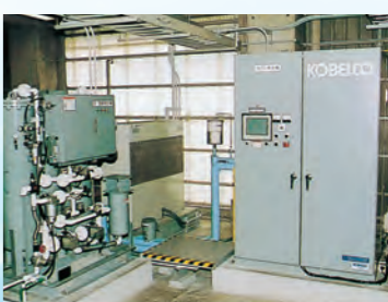
▲再生水プラント(酸素発生機とオゾン発生機)
