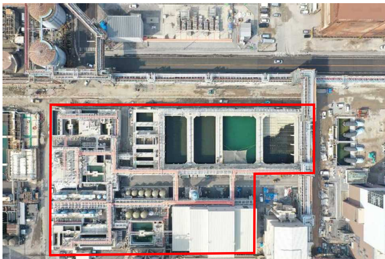
写真 4. 2-2 総合排水処理設備（新設）の設置状況
