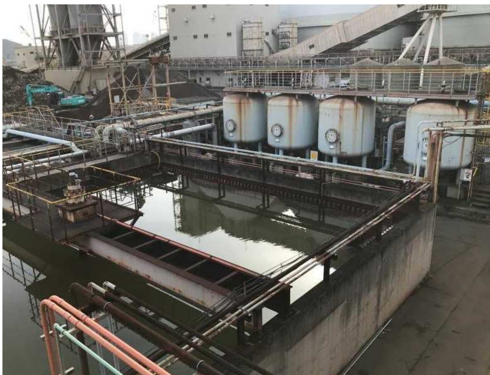
写真 4. 2-1 工事排水処理設備の設置状況
