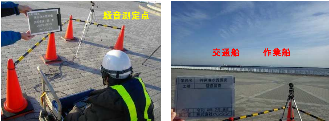
図Ⅱ-2-2 騒音調査地点からみた工事作業状況
