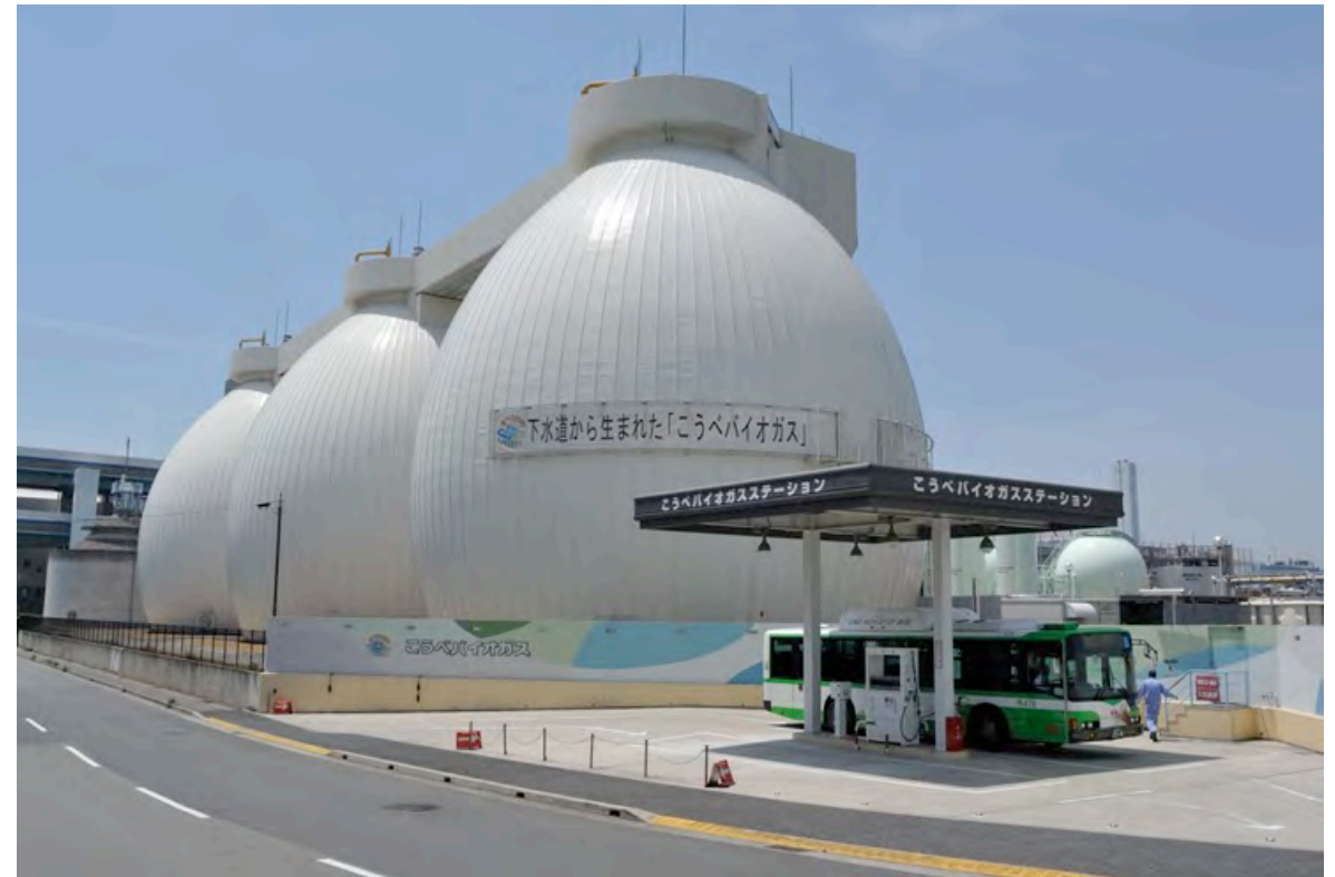
消化タンク（卵型）とこうべバイオガスステーション（東灘処理場）
