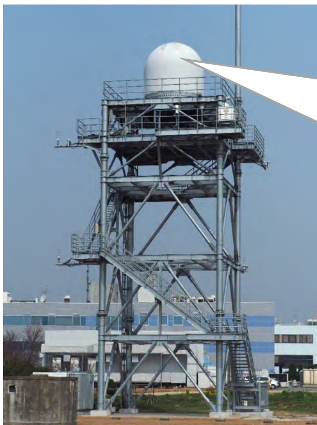
未来ICT研究所（神戸）に設置された フェーズドアレイ気象レーダー（高さ約20m）
