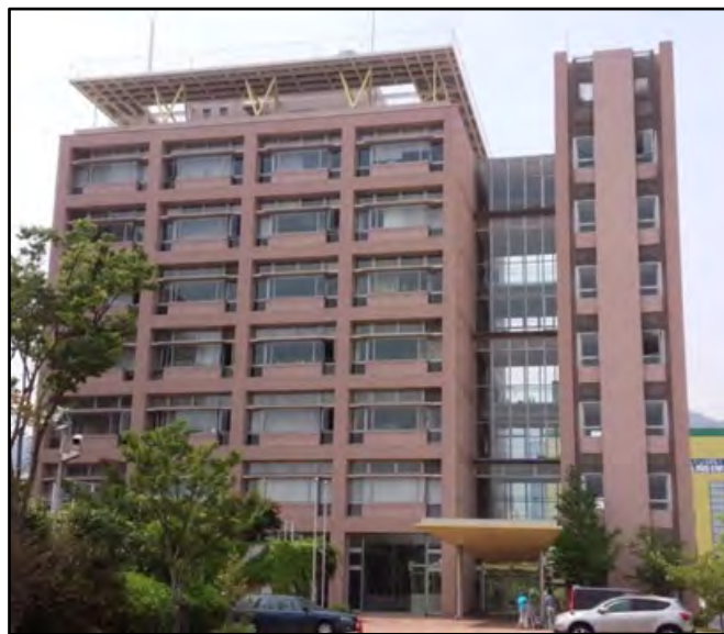
神戸防災合同庁舎
