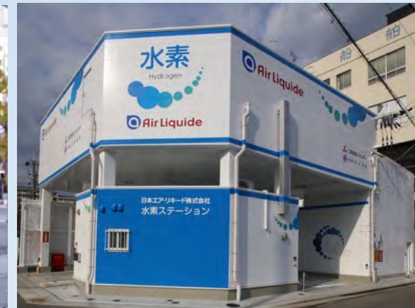
神戸七宮水素ステーション ©2023 Air Liquide Japan
