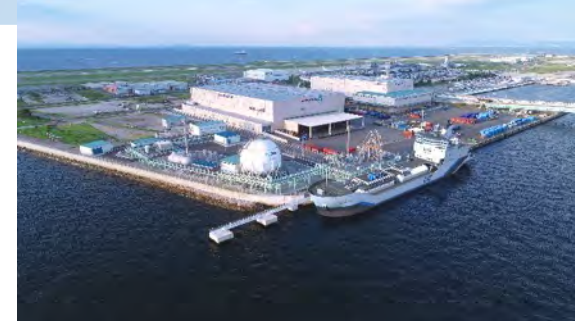
神戸空港島の液化水素貯蔵・荷役基地 Hy touch神戸
