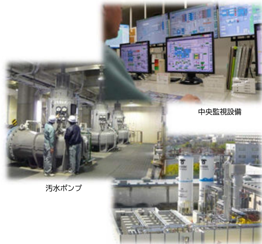
消化ガス精製・発電設備
