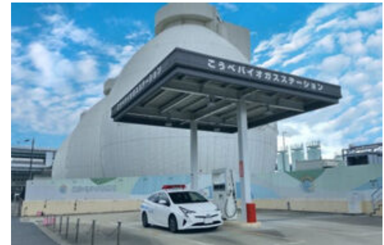
こうべバイオガスステーション（東灘処理場）
