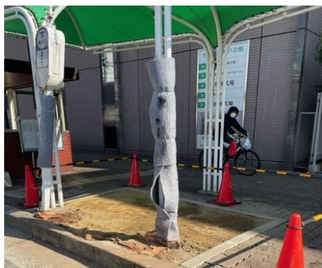
街路樹伐採施工後
