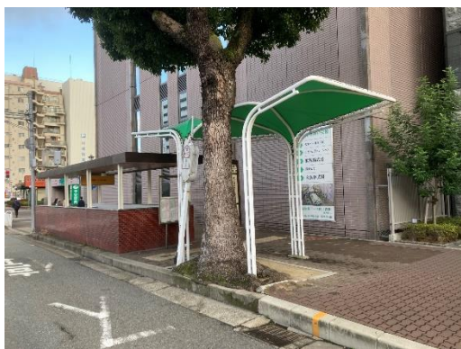
街路樹伐採施工前
