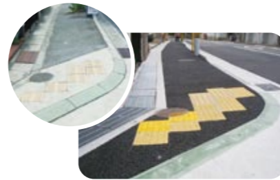
▲ 歩道の段差解消
