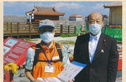
首里城正殿等の再建中の現況を専門官から聴取し視察する（令和8年再建復興予定）
