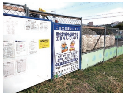
雨水幹線今津地域の現場
