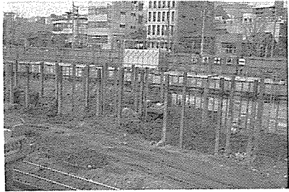
写真 78 工事中のフォレスト六甲
