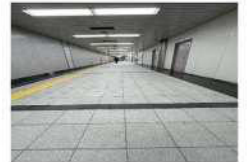
▲地下鉄ハーバーランド駅(清掃後)
