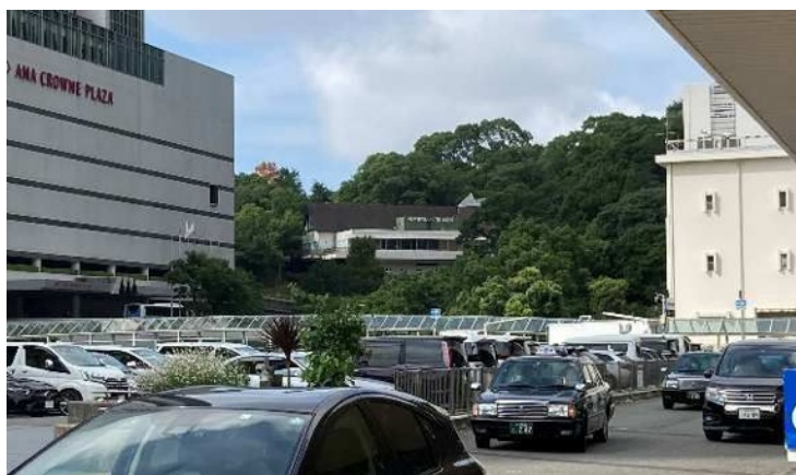
新神戸駅から見た布引ロープウェイ山麓駅（現況）
