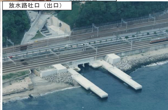
幅、高さとも6.4mの馬蹄形断面
