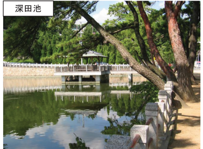
烏原川1号調節池
