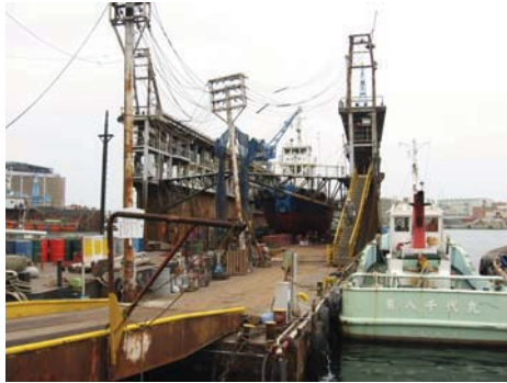
・浮ドックでの造船の様子（西出町）
