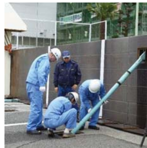
・防潮堤鉄扉閉鎖作業
