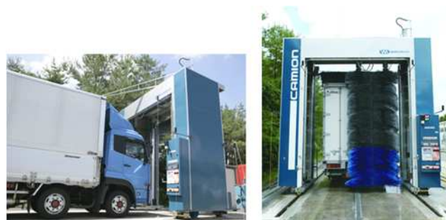
自動式車両洗浄施設
