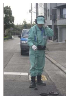
漏水調査の様子
