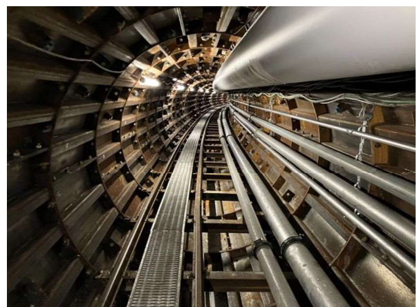
工事中のシールドトンネル
