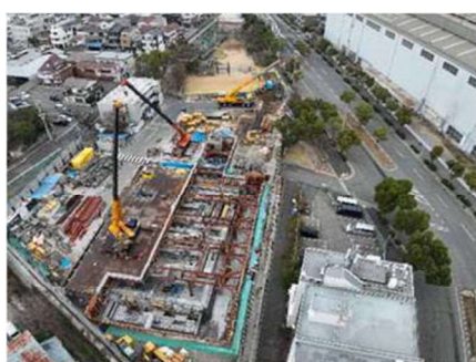
新東川崎ポンプ場整備 (中央区)
