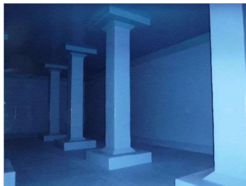
配水池の内面
