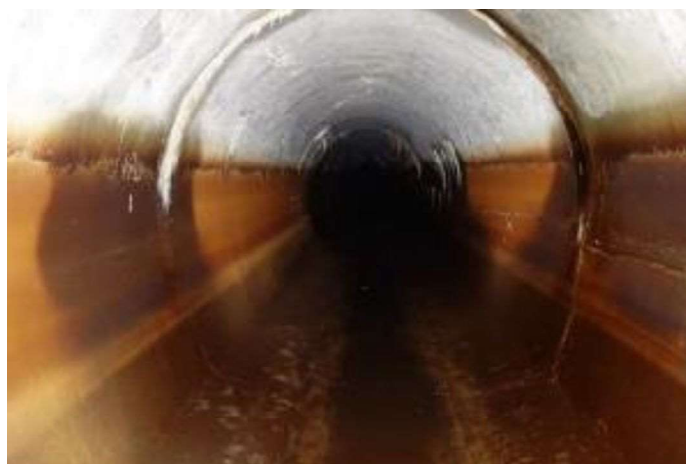
4 拡送水トンネル内部の状況
