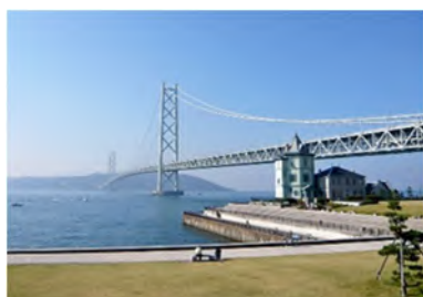
明石海峡大橋
