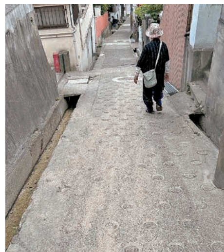
側溝からの冠水で泥が残る道路
